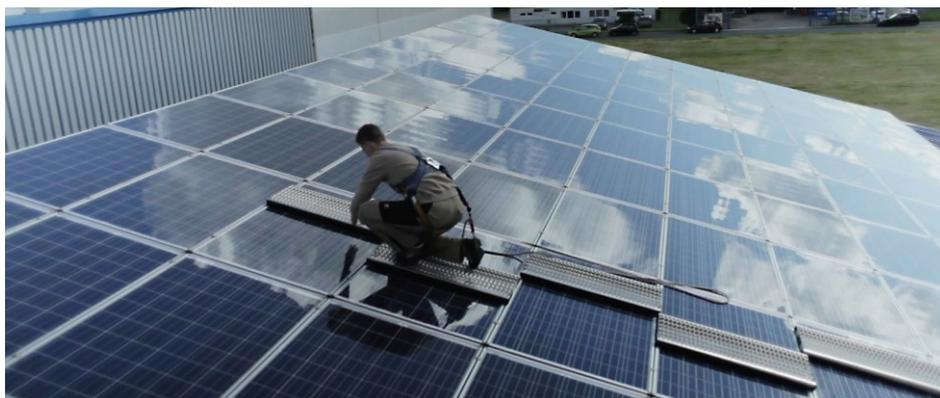
Figura 8: Impiego di una passerella Solar Multiboard, SMB Solar Multiboard GmbH
