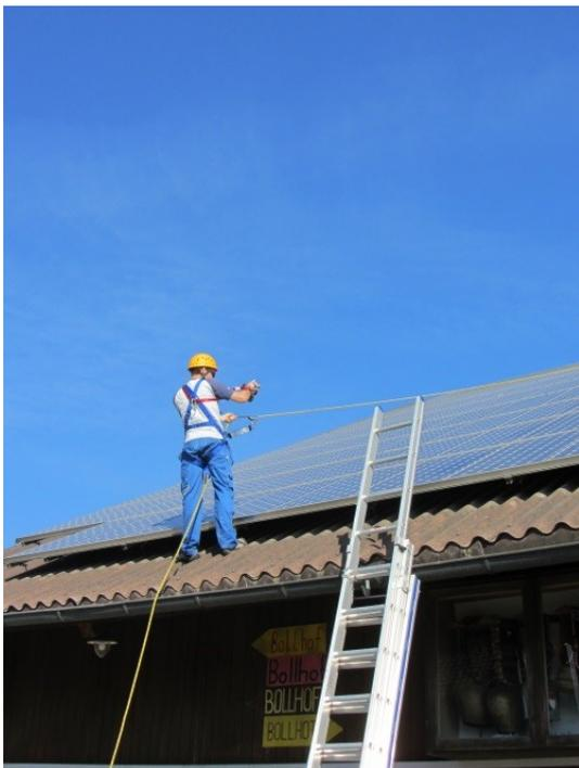
Figura 9: Imbracatura di sicurezza, BE Netz AG
