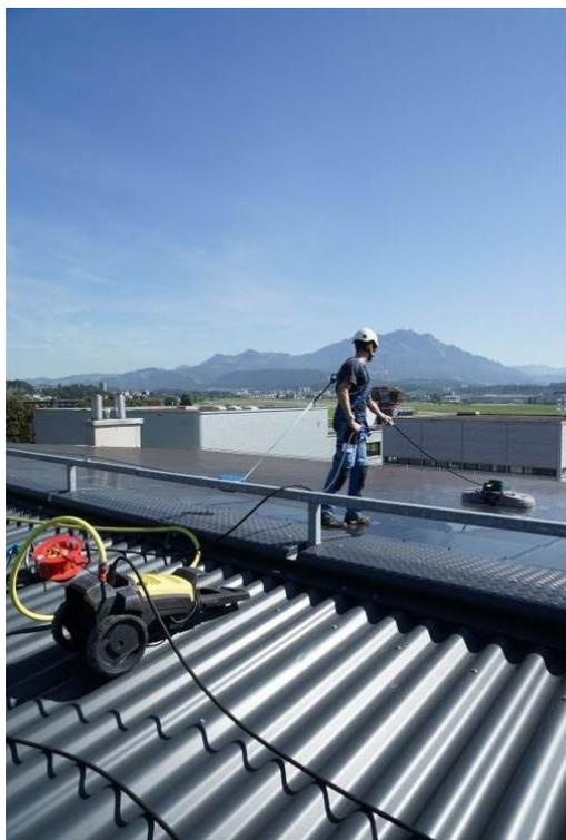
Figura 10: Pulizia di un impianto solare, BE Netz AG
