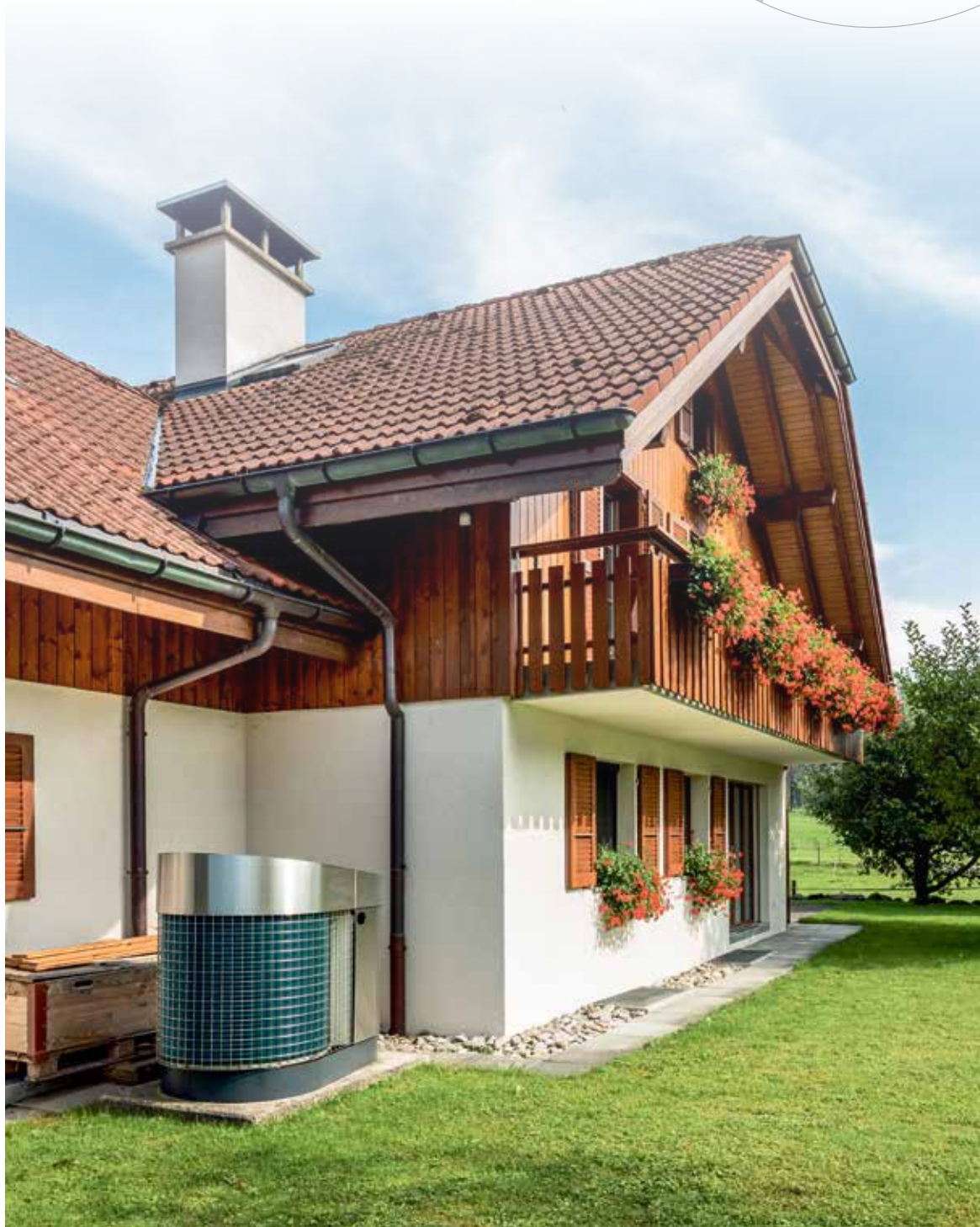
Das Heizen mit erneuerbaren Energiequellen leistet einen Beitrag zum Klimaschutz und ist finanziell attraktiv. Seit einigen Jahren heizt der Eigentümer dieses Einfamilienhauses in Wiggen mit einer Wärmepumpe.
