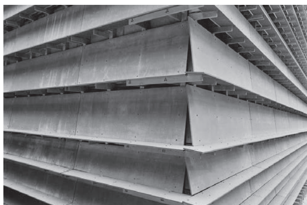
Il modello per eccellenza: il deposito Ricola di Laufen progettato nel 1987 da Herzog & de Meuron. Fotografia: Margherita Spiluttini
