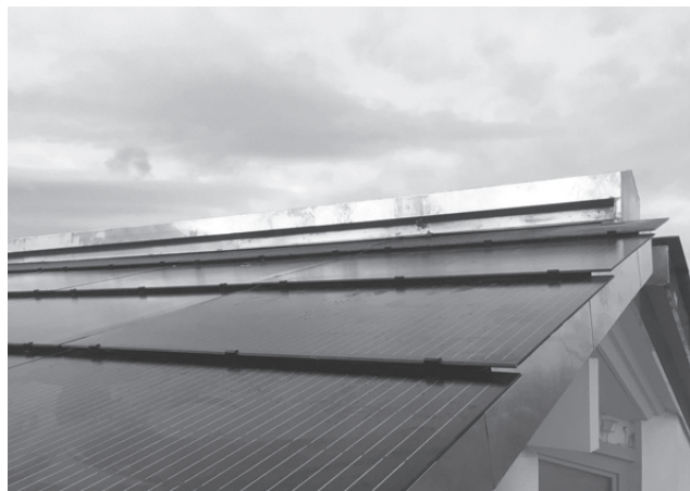
Sottile nonostante il nuovo rivestimento e i collettori ibridi (fotovoltaico e calore): la Chiesa di Ebmingen dopo l'intervento di ristrutturazione di Daniel Studer.
