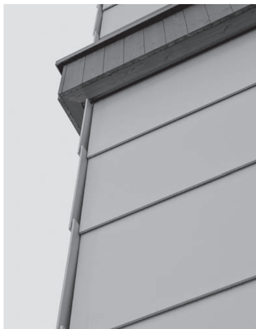
Planarità e fragilità: i pannelli di Eternit della casa plurifamiliare di Zurigo-Oerlikon di Lütjens Padmanabhan.
