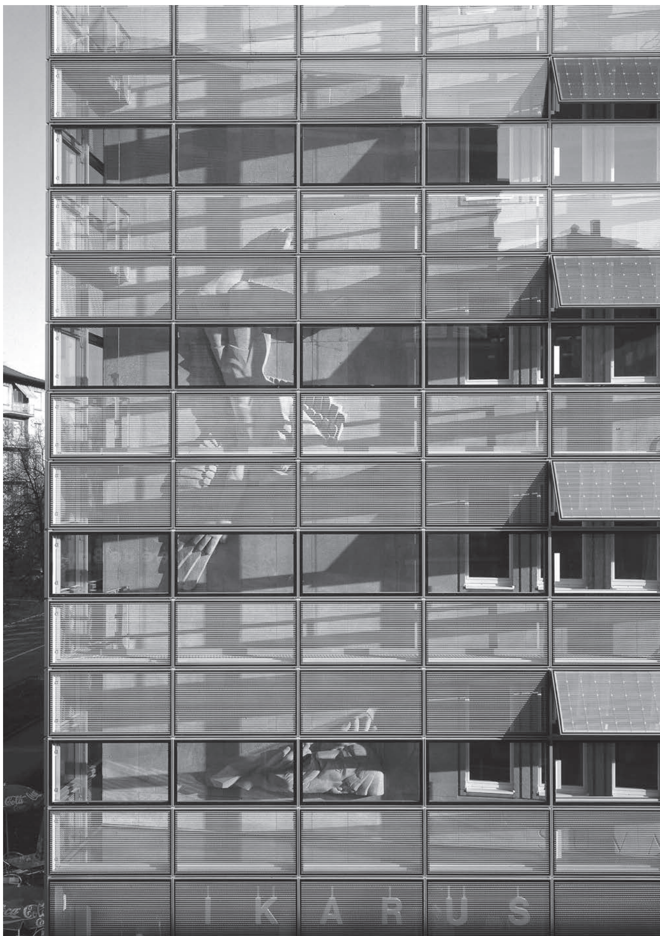
Nell'edificio della Suva di Basilea (1988-93) Herzog & de Meuron per la prima volta stampano il vetro, che avvolge sia l'edificio storico che il nuovo ampliamento. Fotografia: Ruedi Walti
