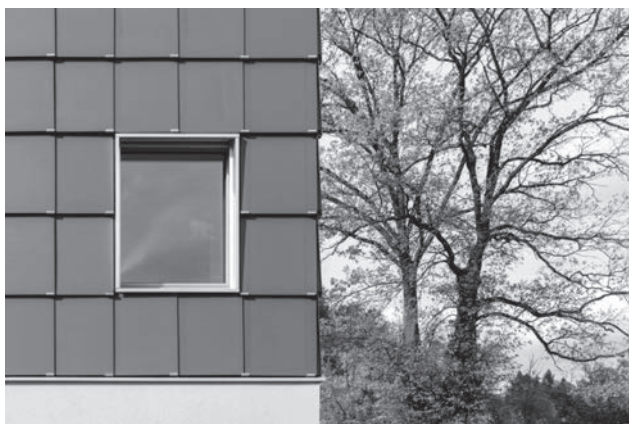
Sulla falsariga di «Bregenz»: la casa plurifamiliare di Zurigo-Leimbach di René Schmid produce elettricità.
