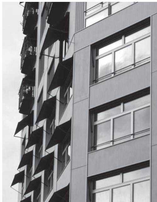
Nessuna giuntura, nonostante i giunti: nella Torre della Weststrasse degli architetti Loeliger Strub i profili in alluminio incorniciano le lastre di fibrocemento.
