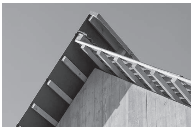
Linea di colmo percettibile: a sinistra i moduli fotovoltaici, a destra gli elementi di Eternit ondolato. La casa monofamiliare di Tamins, di Daniel Ladner, Valentin Bearth e Andrea Deplazes. Fotografie: Ralph Feiner
