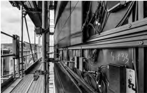
La costruzione della facciata è un'esecuzione speciale realizzata dalla ditta Gasser di San Gallo: gli elementi vetrati sono appesi a binari in alluminio e fissati con viti a brugola attraverso giunti sottili.
