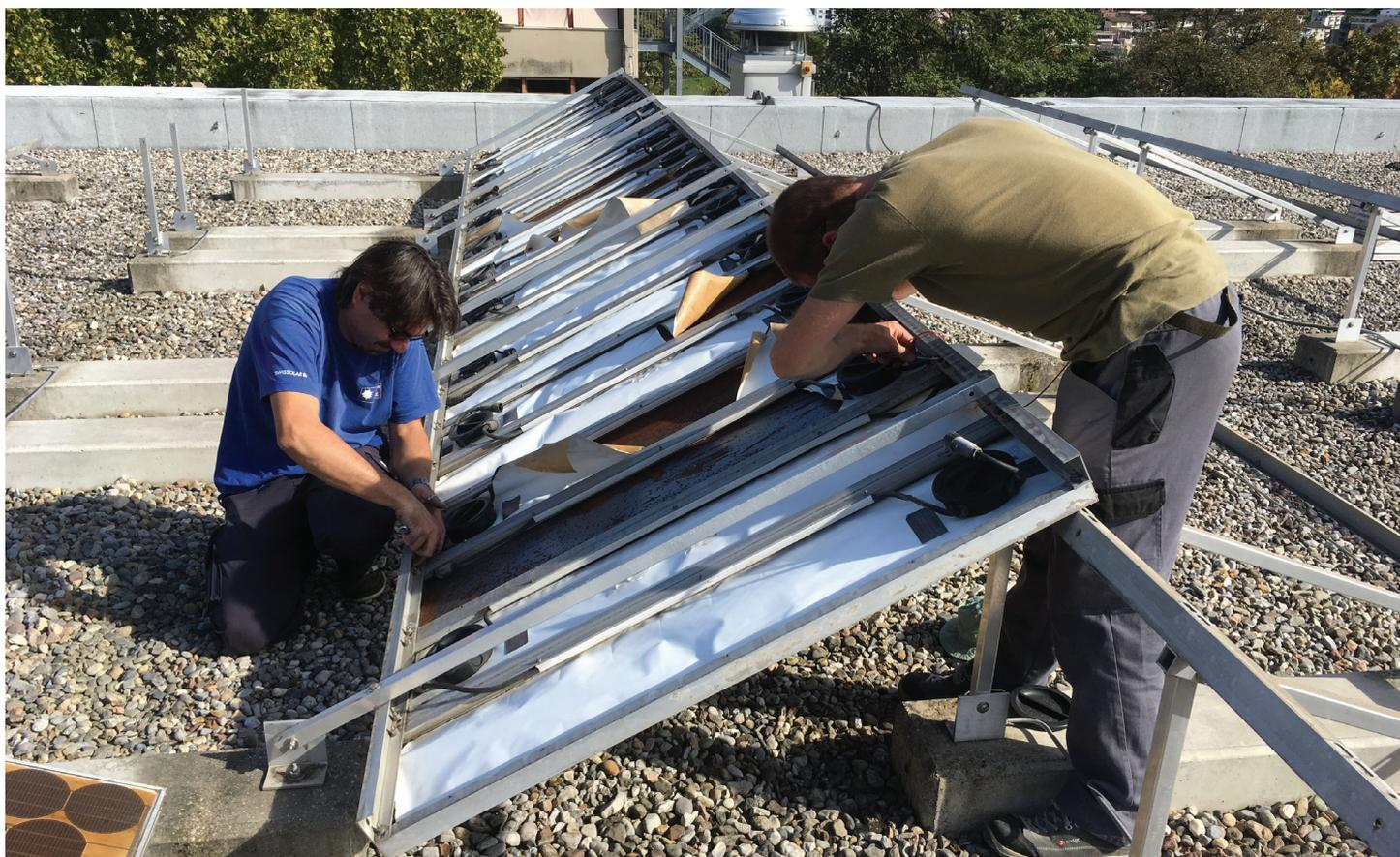
Fino al 2017 l'impianto fotovoltaico TISO-10 è stato installato sul tetto dell'Aula Magna della SUPSI. Successivamente si è provveduto alla sua rimozione per consentire ai ricercatori della SUPSI di analizzare lo stato dei moduli dopo 35 anni di funzionamento. Foto: Rap. finale TISO 35+
