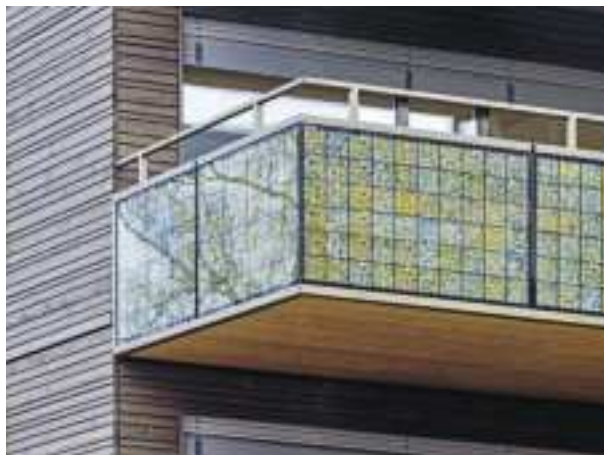
PARAPETTI DI BALCONE CON MODULI FV POLICRISTALLINI PER UNA CASA PLURIFAMILIARE NELLA ZWYSSIGSTRASSE, ZURIGO
