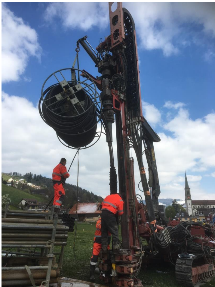
Figura 2: posa di una calza per sonde geotermiche (fonte: CSD Ingegneri SA)
