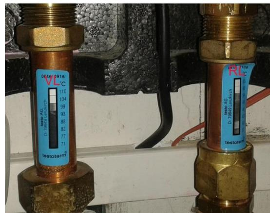
**Fig. 4:** Strisce termometriche sulla linea di mandata/ritorno del circuito solare. Una stagnazione creata allo scopo è segnalata con 108°C sulla linea di ritorno.
