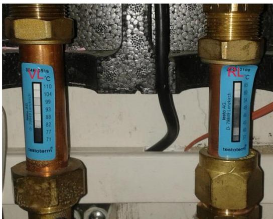
**Fig. 3:** Strisce termometriche sulla linea di mandata/ritorno del circuito solare. Dopo 4 settimane indicano 77°C alla mandata e 54°C al ritorno.
