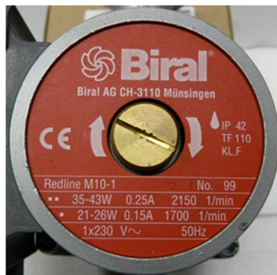
Figura 2: targhetta pompa. Fonte: Biral Redline M10-1
