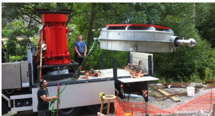
Installazione della turbina e del generatore presso la centrale di Pied du Mont (immagine: Gasa Hydro SA)
