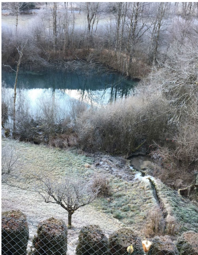
Il biotopo Bief Rouge è stato originariamente costruito per raccogliere le acque reflue del tunnel del Mont d'Or e per impedire l'inquinamento del fiume Orbe (Fonte immagine: VO Energies)
