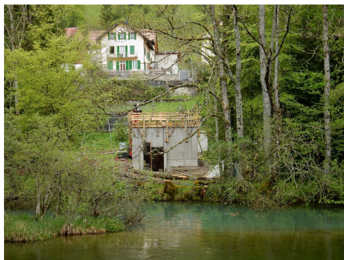
Costruzione della centrale idraulica Bief Rouge sulla riva dell'Orbe (Fonte immagine: VO Energies)
