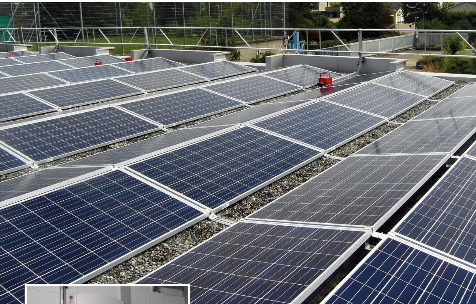
Moduli fotovoltaici con orientamento est/ovest posati su un tetto piano
