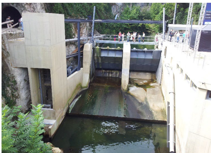
Ascensore per pesci presso la centrale di Orbe, VD (Foto: Mhylab)
