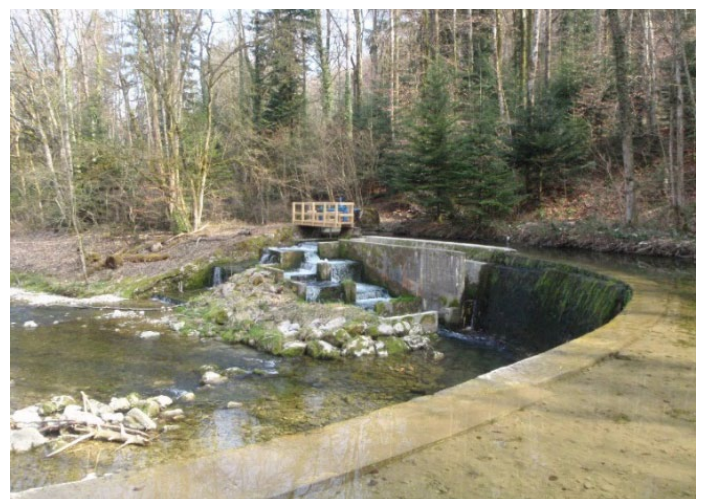
Passaggio a bacini intagliati sul fiume Arnon, presso il centro Moulin de Pérosset (Fiez, Vaud, Foto: Mhylab)
