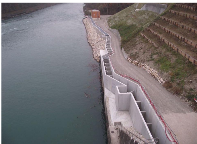
Opera per la risalita dei pesci a Chancy-Pougny sul fiume Rodano (Foto: SFMCP)
