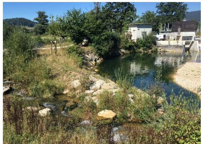
Sbocco del bacino d'aggramento per la risalita dei pesci presso la centrale Grand Ecluse (si veda anche la sezione «Comunicazioni», Foto: SID)
