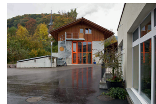
La centrale termica, munita di caldaia, accumulatori di acqua calda e silo di stoccaggio, sorge accanto al caseificio.
