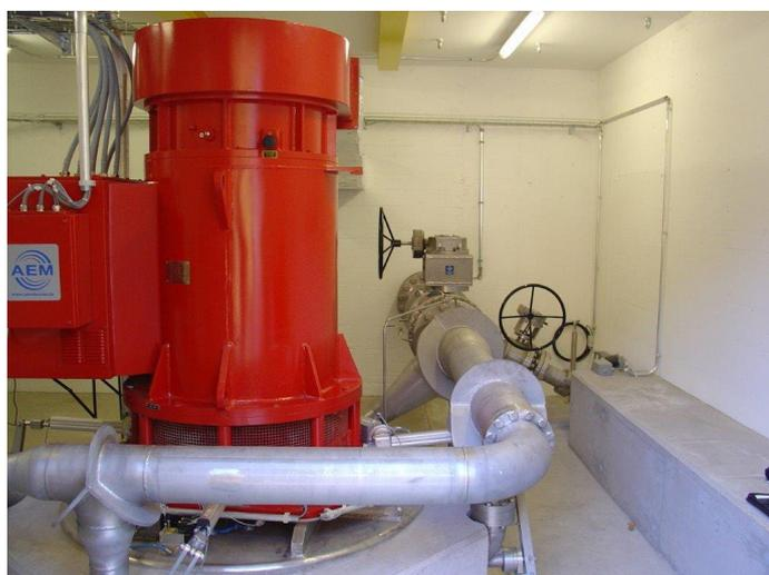
Sala macchina della centrale di Arbaz II: turbine e generatore con bypass e valvola di riduzione della pressione (Fonte: Gasa Hydro SA)
