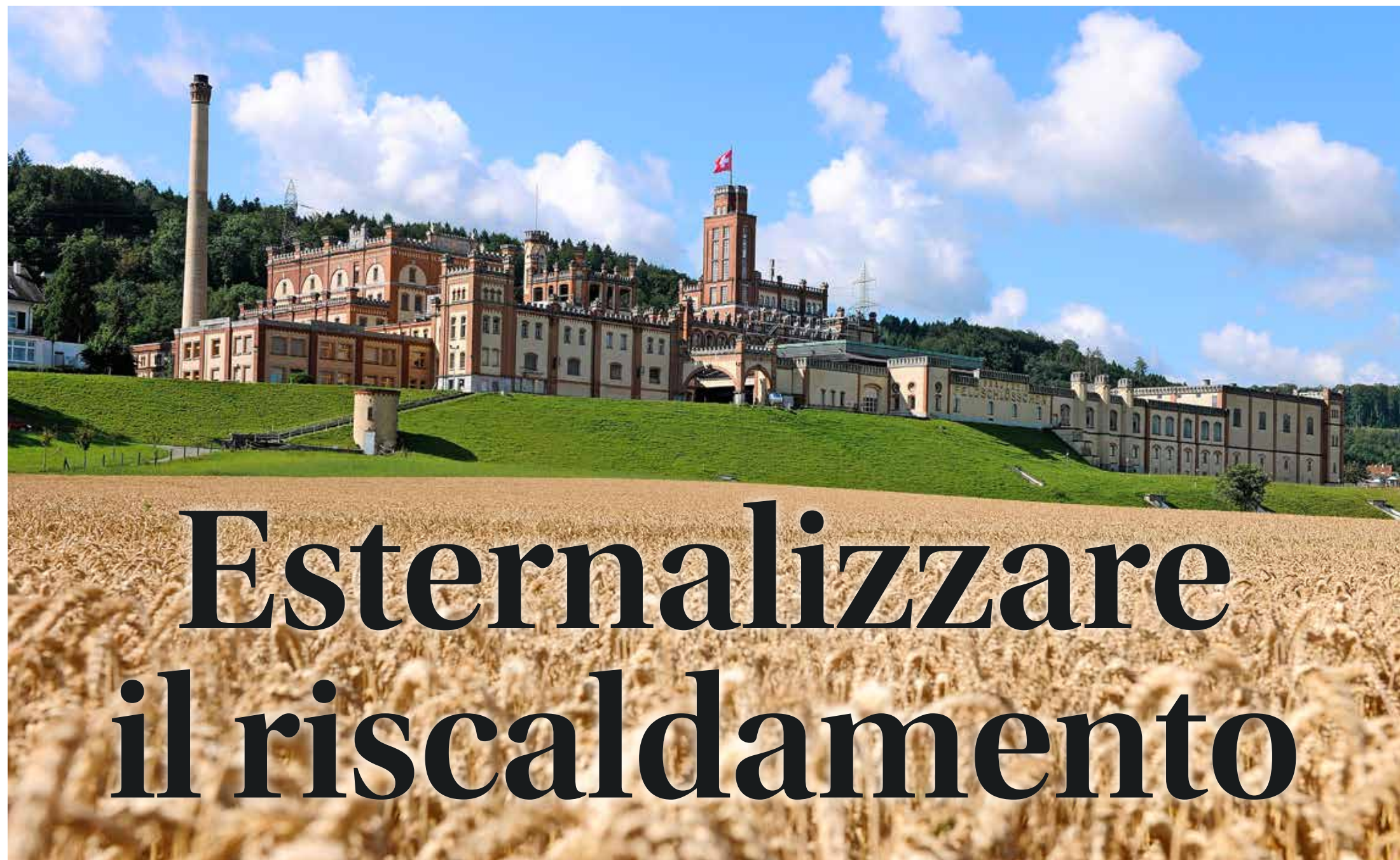
Consorti di riscaldamento Rheinfelden AG: anche il calore dell'impianto della Feldschlösschen Getränke AG è utilizzato e immesso nella rete di teleriscaldamento del consorzio.
