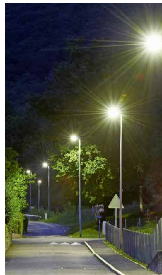
Passaggio ai LED: l'illuminazione stradale di Lumino ora consuma due terzi in meno di corrente.
