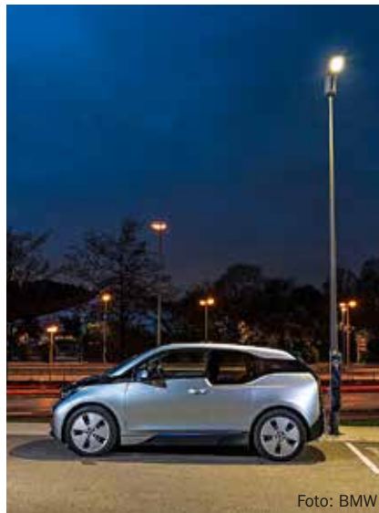
Doppia utilità: lampade LED stradali fungono da stazione di ricarica di auto elettriche.
