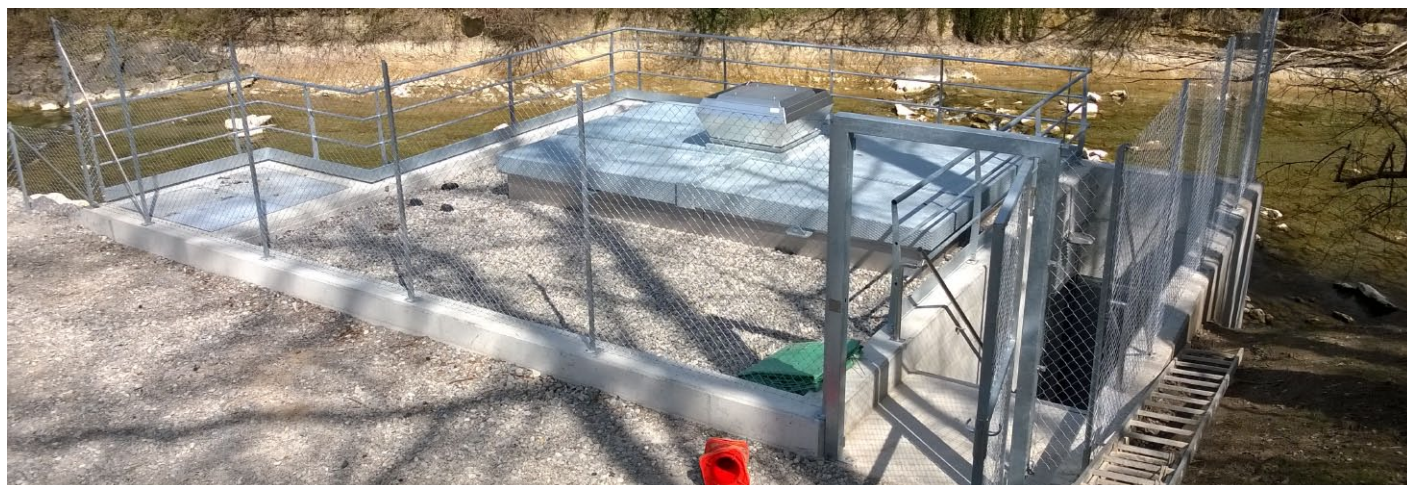
Il locale di turbinazione sulle rive della Töss
