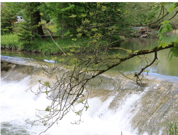
Sbarramento della piccola centrale idroelettrica Ste. Apolline durante il convegno ISKB
