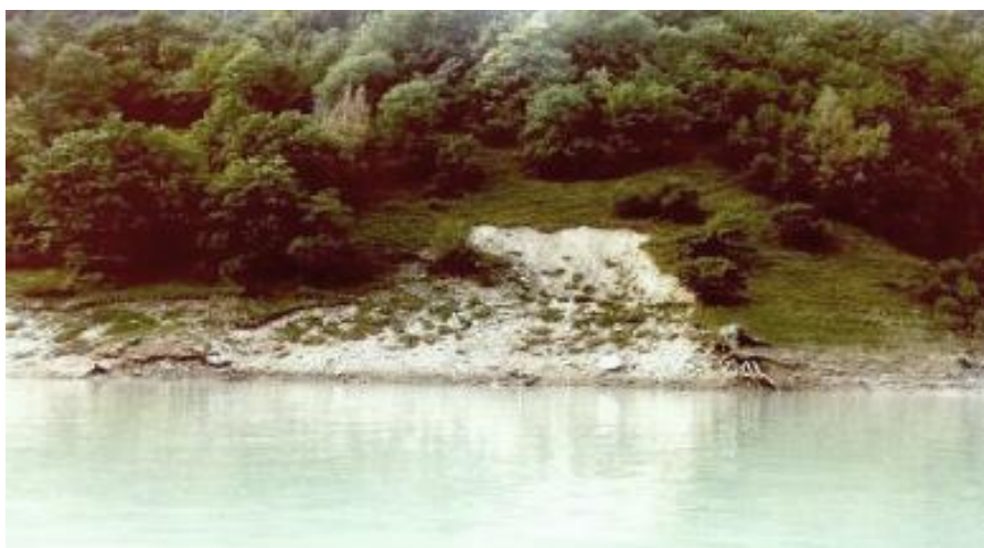
Figura 8e: instabilità delle rive
