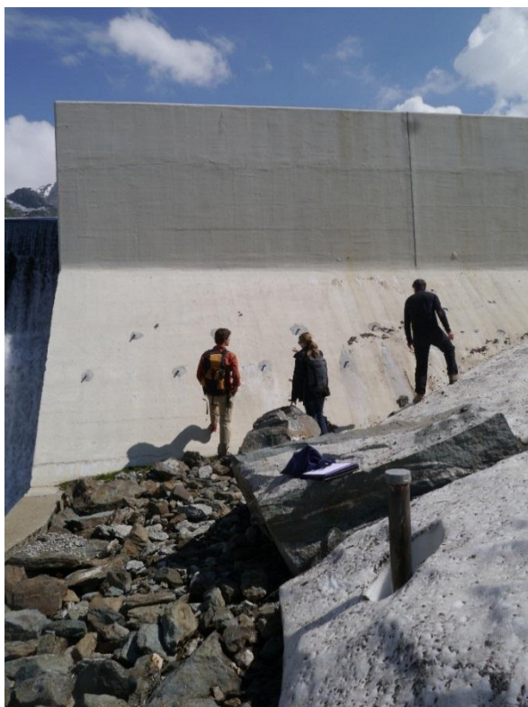
Figura 7: controlli visivi, impianto di accumulazione Louvi, VS
