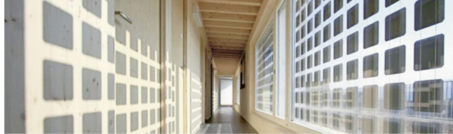
Foto: moduli PV in facciata nel rinnovamento Minergie-P di un edificio plurifamiliare a Wettingen | © Miloni Solar AG, Wettingen
