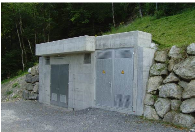
La centrale Châble II del Comune di Vionnaz, integrata nell'approvvigionamento con acqua potabile (© Comune di Vionnaz)
