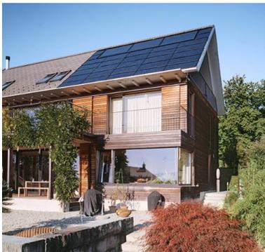
**Figura 2: Sistema solare fotovoltaico integrato in un tetto a Mettmenstetten, Svizzera. Fonte: [www.bipv.ch](http://www.bipv.ch).**
