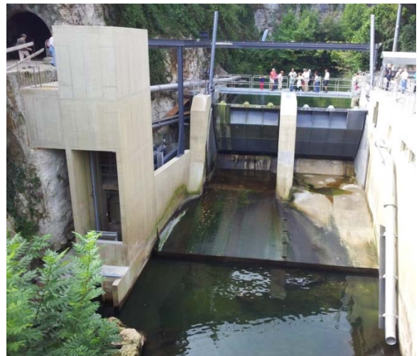
Piccola centrale idroelettrica Moulinets a Orbe (VD), con rampa per castori, lift per i pesci, alette mobili e la sala macchine 15
