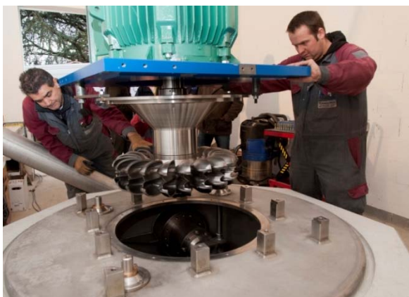
Montaggio della nuova unità di turbina nella centrale di acque reflue Coppet, www.sitse.ch/new/epuration.php 16
