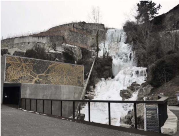
Tronco autostradale di Forestay, parallelo alla centrale Moulins de Rivaz (VD): in caso di temperature basse, il concetto di deflusso residuale acquisisce un altro significato (Foto: Romande Energie)
