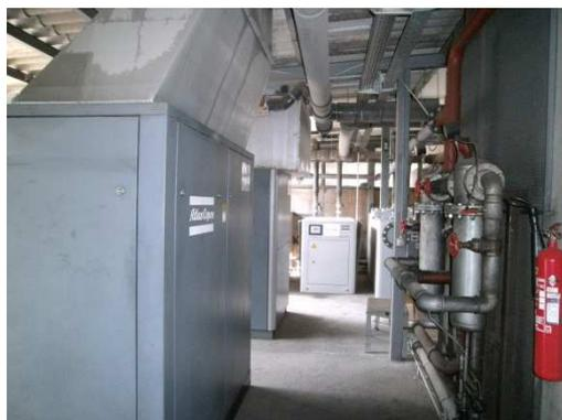
I compressori d'aria compressa di nuova generazione consumano meno elettricità, perché lavorano solo per raggiungere la pressione dell'aria definita. I modelli di vecchia generazione girano anche a vuoto, dato che non si può regolare la loro velocità in funzione dell'utilizzazione necessaria.
