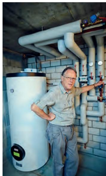
Foto grande: la centrale termica della rete di teleriscaldamento di Blaufuhren è alimentata a cippato. Da sinistra: Beat Gehrig si occupa dell'esercizio, Fritz Kobel delle finanze, Kurt Mosimann è l'iniziatore del progetto e Hans Sommer ha costruito l'impianto. Foto piccola: il boiler nella cantina di Kurt Mosimann è oggi dieci volte più piccolo.
