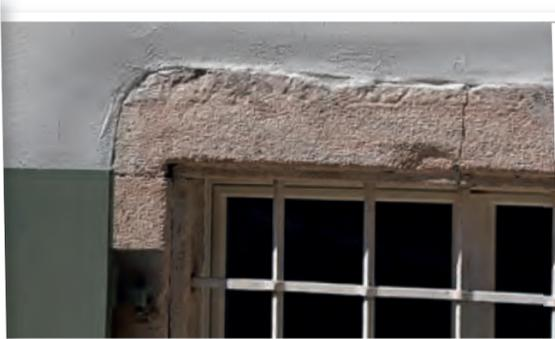
L'intonaco isolante si applica in uno strato sottile alle vecchie murature, evitando di coprire le cornici delle finestre.
