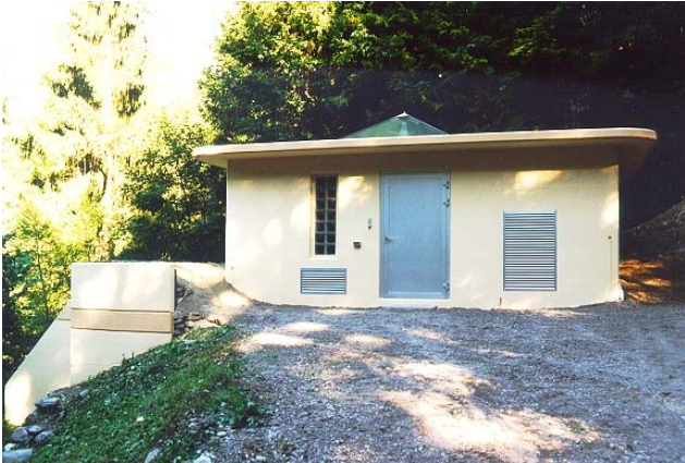
La centrale idroelettrica, alimentata da acqua potabile, di La Rasse, installata nella riserva di acqua potabile dei comuni di St-Maurice ed Evionnaz.
