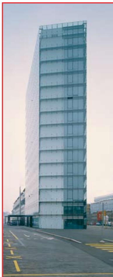
Posti di lavoro sani presso l'edificio amministrativo nella zona «Gare de Neuchâtel» (NE-001-ECO).
