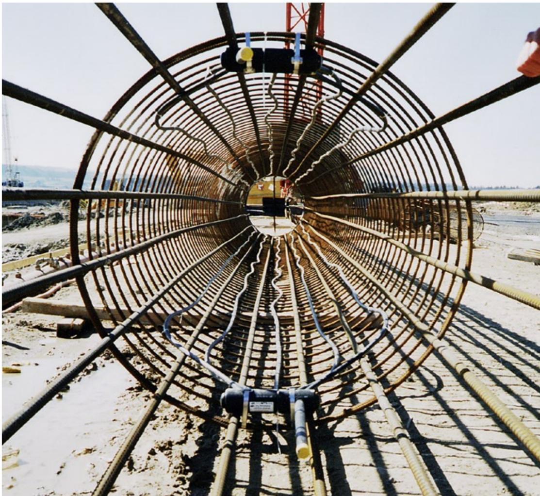
I pali energetici, come quelli utilizzati nella costruzione dell'Aeroporto di Zurigo, offrono scambio termico e stabilità.
