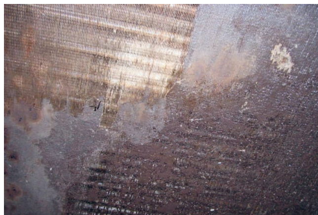
Foto: Sporco su un raffreddatore ad aria, le lamelle si stanno intasando.
