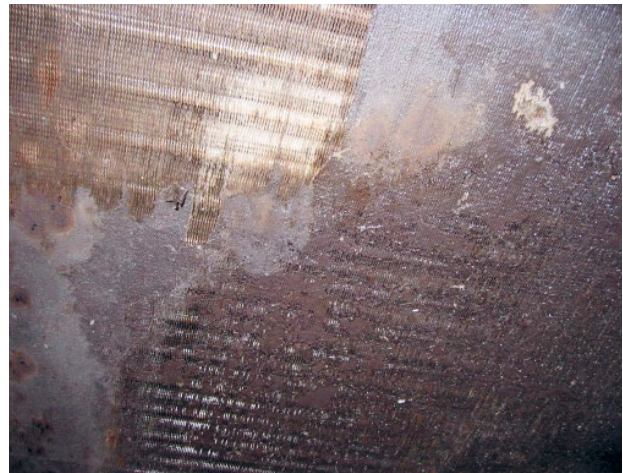
Foto: Sporco su un raffreddatore ad aria, le lamelle si stanno intasando.
