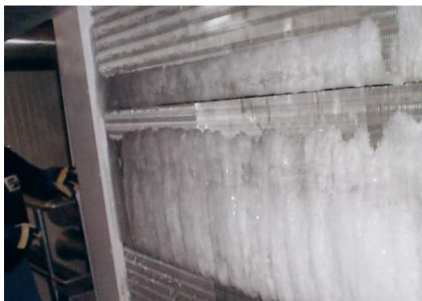
Figura: evaporatore ghiacciato. L'aria attraversa soltanto una parte della superficie.
