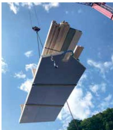
*Per eseguire i lavori di ristrutturazione era in servizio una gru di 45 m, dato che l'edificio era raggiungibile solo a piedi. (foto: Martin Zeller)*
