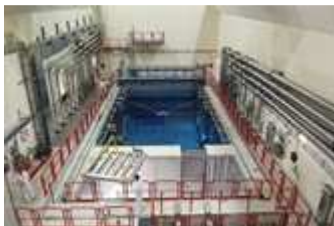
Gli elementi di combustibile vengono immagazzinati anche in depositi intermedi delle centrali nucleari (Immagine: piscina di raffreddamento della centrale nucleare di Gösgen). Fonte: Centrale nucleare di Gösgen
