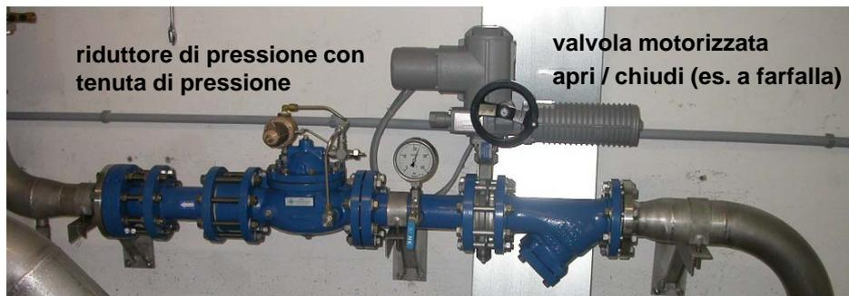
riduttore di pressione con tenuta di pressione
