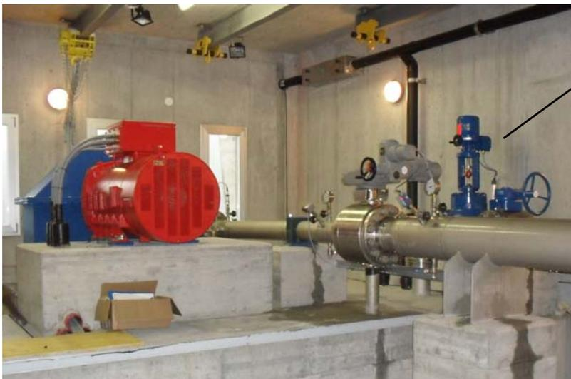
valvola motorizzata (a pistone o a stantuffo) di riduzione della pressione e di regolazione della portata (regolazione del grado di apertura in funzione del livello a monte)
