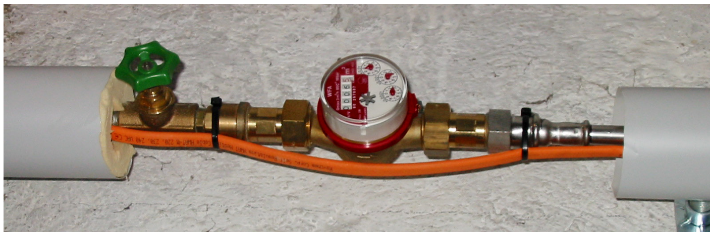
Fig. 5: nonostante il calore del cavo riscaldante, a causa delle notevoli perdite termiche si creano un «punto di prelievo freddo» e forti perdite. La coibentazione deve essere completata, lasciando due aperture per la manopola e il contatore (foto J. Nipkow)
