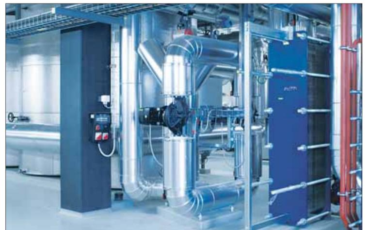
**Serbatoi per l'accumulo di calore (a sinistra) con scambiatori di calore (a destra) per il recupero del calore residuo dei compressori.** (Foto: Regula Roost)
