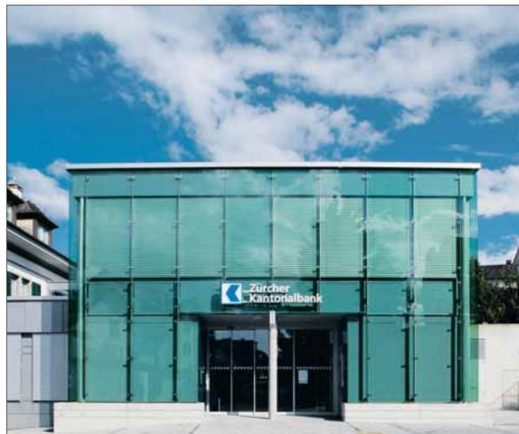
**Banca cantonale zurighese a Rütli: la facciata a doppio rivestimento realizzata dalla Blaser Metallbau AG soddisfa tutti i requisiti di sicurezza di una banca.**
