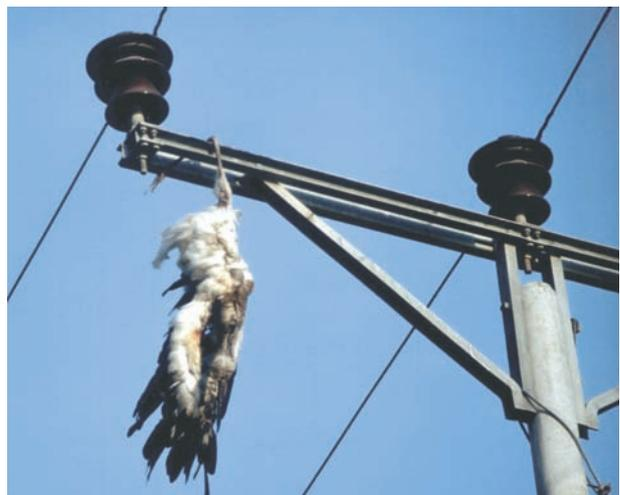
*Fig. 2: Una cicogna bianca morta in seguito a folgorazione su un traliccio con isolatori rigidi. Un'altra cicogna giaceva morta per terra. (foto: G. Fiedler)*
