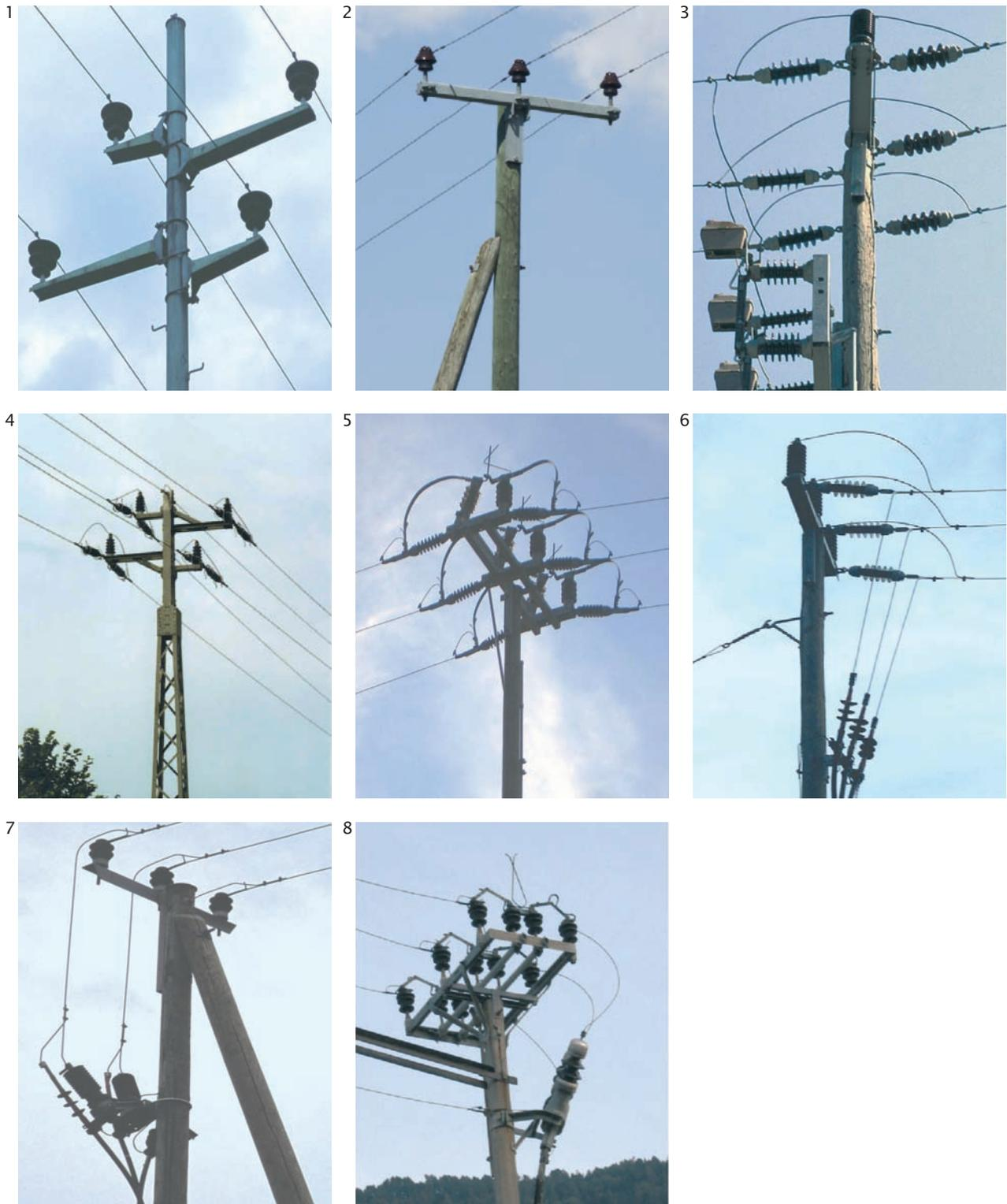
*Fig. 4: La maggior parte degli incidenti accadono su sostegni con isolatori rigidi e conduttori al di sopra della mensola (1-8), in caso di interruttori da palo costruiti in modo pericoloso (5, 8) e in caso di sostegni terminali (con o senza interruttori 6-8). (foto: A. Aebischer e FFS)*
