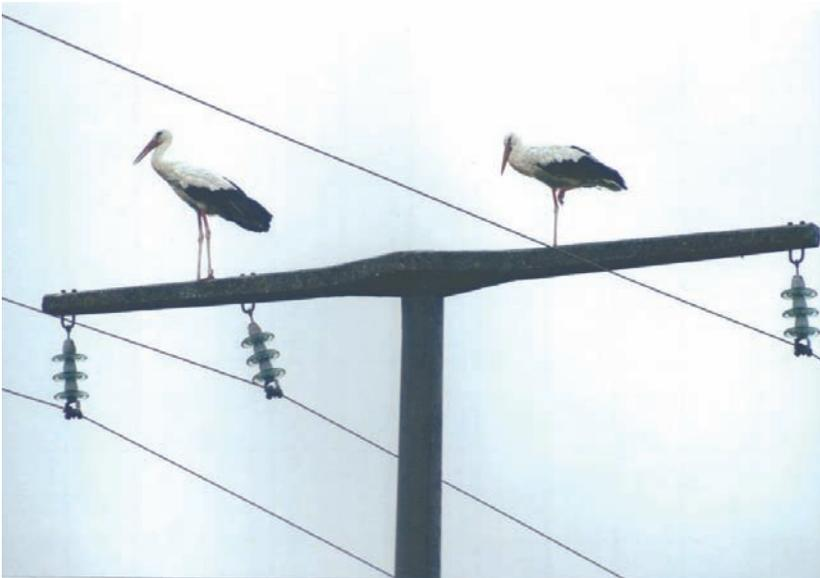
*Fig. 10: Cicogne bianche su un sostegno con isolatori sospesi senza rischi per i volatili. La distanza tra il bordo superiore della mensola e i conduttori dovrebbe essere di almeno 60 cm. (foto: G. Fiedler)*
