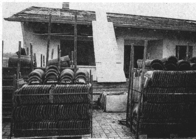
Figura 4-2 Scopertura del tetto e raccolta ordinata delle tegole
