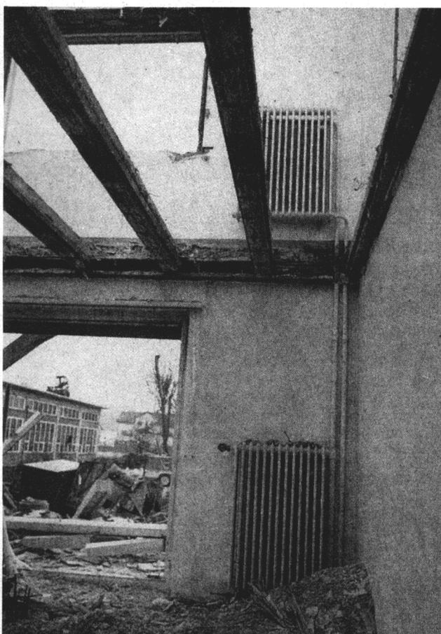
Figura 4-3 Smontaggio fino alla struttura portante
