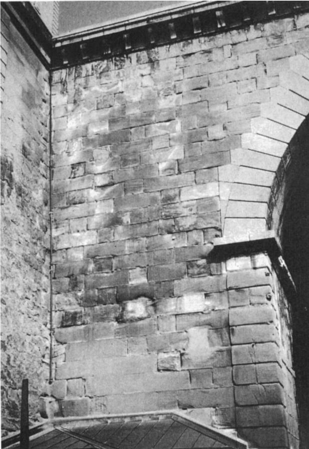
*Figura 7.9* Situazione di danno al ponte Nydegg; l'acqua discendente provoca una forte dis-sabbiatura a causa della cristallizzazione del sale.
