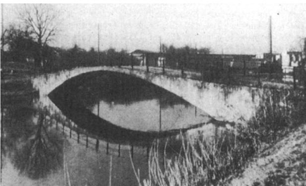
Figura 4.1 Primo ponte in cemento armato in Svizzera costruito nel 1890 sopra un canale di servizio di una fabbrica a Wildegg [4.1].
