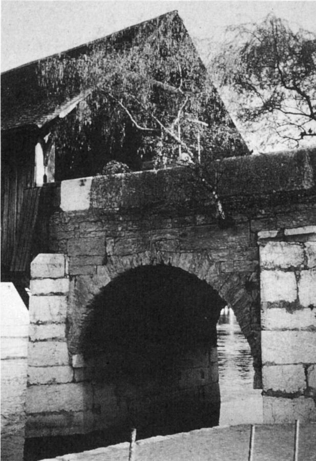
*Figura 7.11 Rottura della muratura a causa della penetrazione di radici di una betulla sul «ponte in legno» a Olten.*
