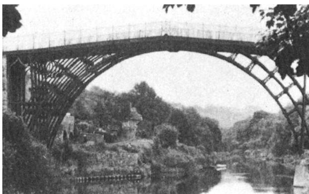
Figura 5.1 Ponte ad arco in ghisa sul Severn presso Coalbrookdale - luce 30 m [5.1]
