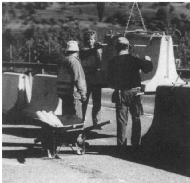
Illustrazione 64: montaggio degli elementi Tric-Bloc
