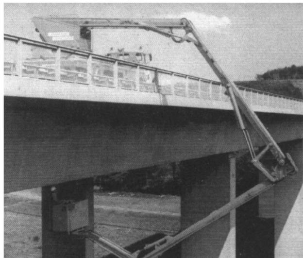
Illustrazione 49: utilizzazione di un braccio per l'ispezione di un ponte
