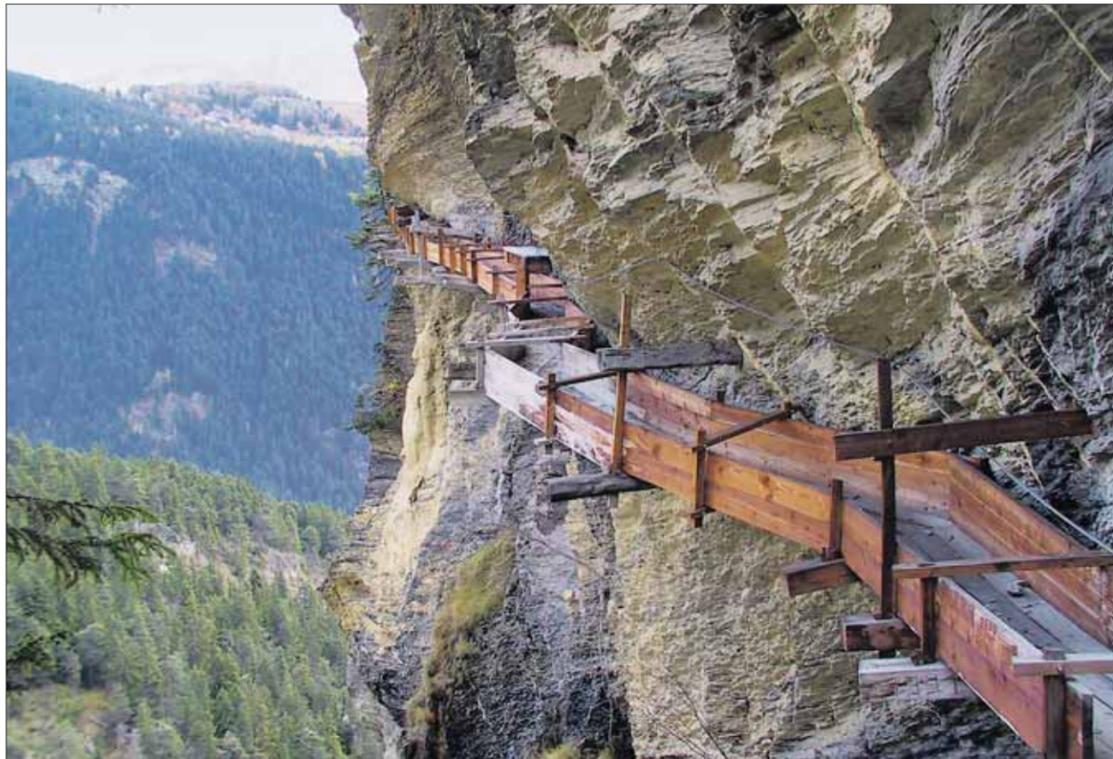
I «Bissen» o «Suonen» - così sono dette le condutture idriche del Vallese - fanno parte di una rete di canali aperti vecchi di oltre 2000 anni, che ad Ayent si usano ancora oggi per irrigare campi e vigneti.
