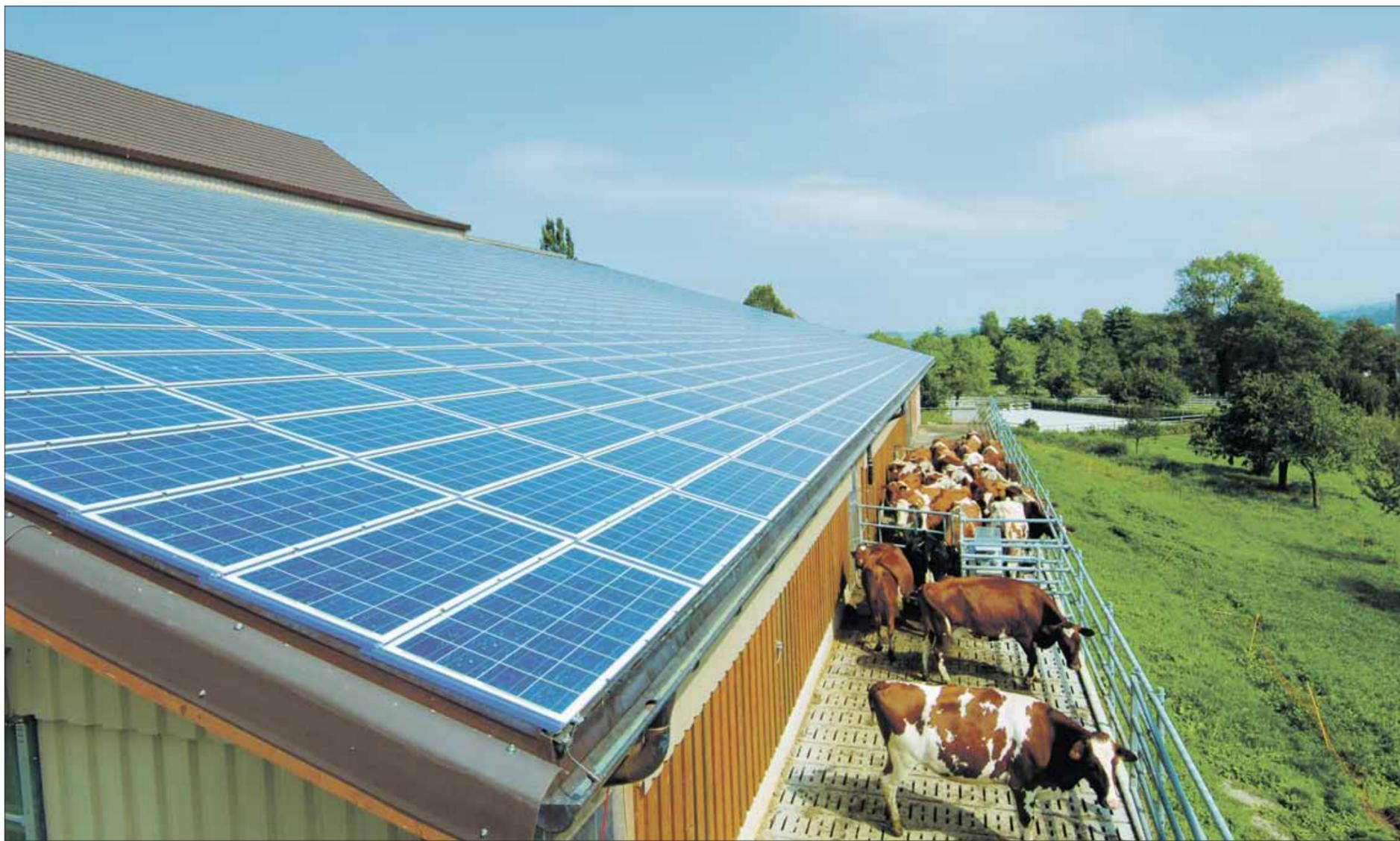
L'impianto solare installato sul tetto della stalla misura 960 m<sup>2</sup> e copre oltre il 300 per cento del fabbisogno energetico dell'azienda. (Foto: Karl-Heinz Hug)
