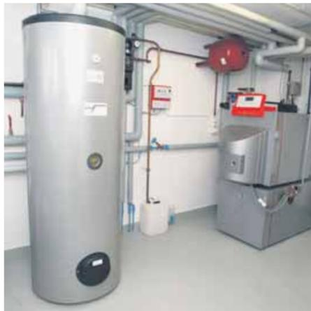
**Un moderno riscaldamento a olio combustibile garantisce un'efficace generazione di calore.**
