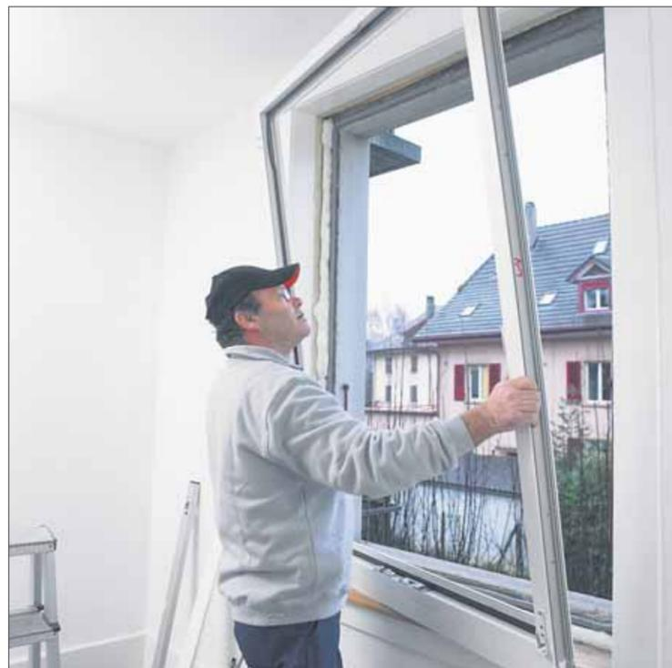
**4** Precisione millimetrica: il nuovo telaio combacia perfettamente con la luce della finestra.
