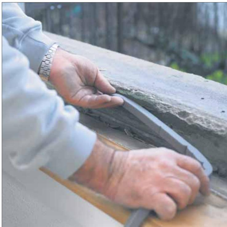
**2** Il nastro ermetico impedisce all'aria fredda di infiltrarsi tra il muro e la finestra.
