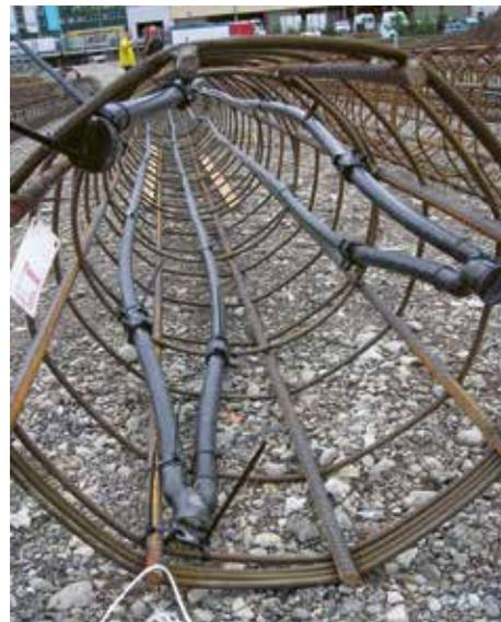
Figura 4.7: Gabbia di rinforzo del palo con sonde fissate (fonte: HakaGerdur).
