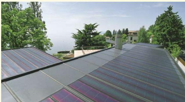
Impianto PV con celle a film sottile di silicio amorfo. (Frédéric Pachoud)
