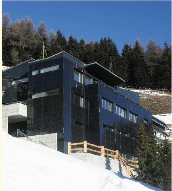
*Integrazione ottimale: in questo edificio privato i moduli fotovoltaici sono un elemento delle facciate (Josef Troxler).*
