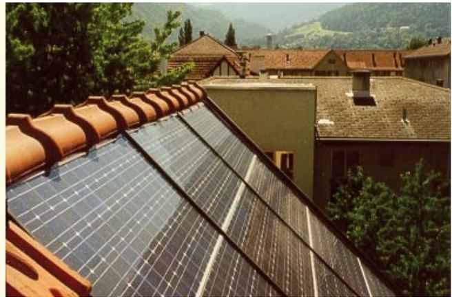
Tetto risanato con installazione di moduli fotovoltaici. (Raimund Hächler)
