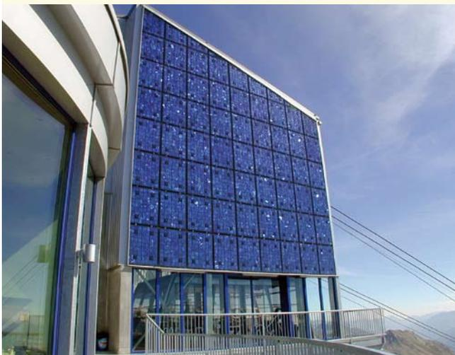
*Impianto PV integrato in facciata, con celle solari policristalline. (NET AG)*
