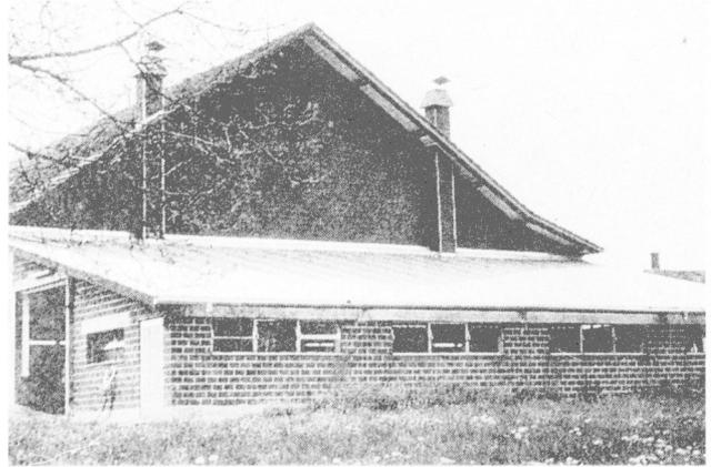
*Questa stalla annessa ha un tetto sotto forma di collettore (190 m<sup>2</sup>) dotato di una copertura trasparente in poliestere. L'aria penetra nel collettore dalla gronda, scorre verso l'alto e viene aspirata dal ventilatore per il fieno da entrambi i lati verso il centro.*
