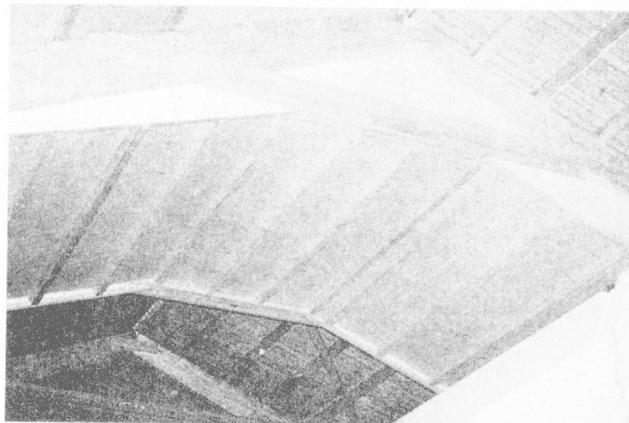
*Canale d'aria posato sul colmo. Con questi canali relativamente lunghi deve essere prestata una particolare attenzione alla sezione trasversale perchè potrebbero verificarsi delle perdite di pressione troppo elevate.*
