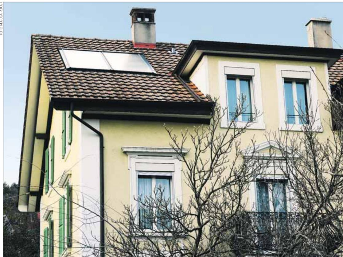
Per prima cosa, sono stati installati i collettori solari per la produzione di acqua calda. Gli altri lavori in programma sono l'isolamento interno del tetto, le finestre termoisolanti e il riscaldamento a pellet.
