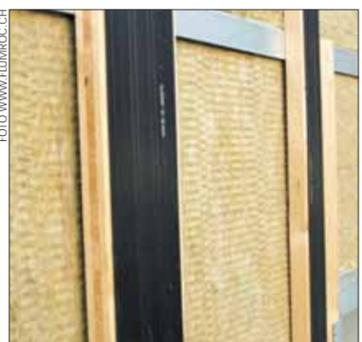
Nel caso della facciata ventilata, per il rivestimento c'è bisogno di una sottostruttura.
