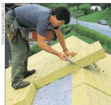
Il fondo piano facilita il montaggio in caso di isolamento esterno.
