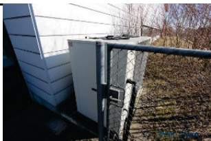
Figura 5: refrigeratore per aerazione produzione
