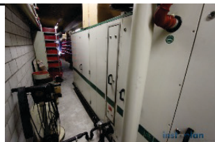
Figura 6: batteria di raffreddamento monoblocco
