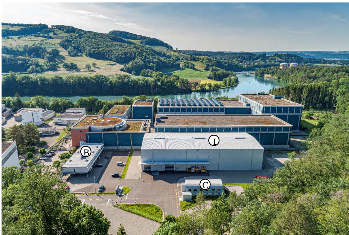
Fig. 3-6: Situation heute (Blickrichtung Nordwest): Die Gebäude B (Bürocontainer), C (Hauswartgebäude) und I (Lagerhalle) müssen für den Neubau der BEVA am Standort Zwiilag rückgebaut werden
