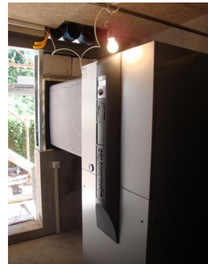
Pompa di calore aria-acqua
