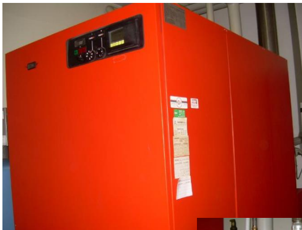
Caldaia a gasolio
