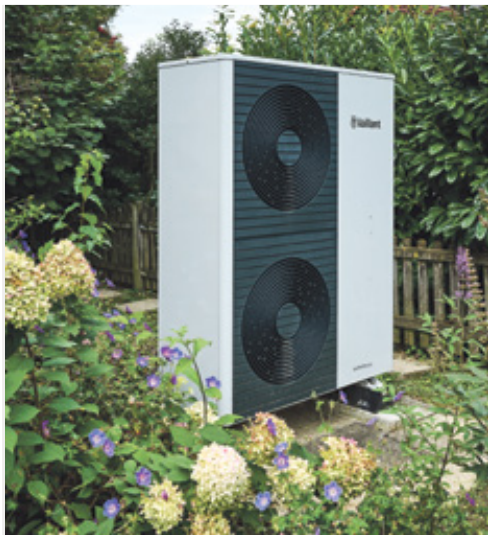
Parte degli interventi di risanamento energetico: la pompa di calore aria-acqua.
