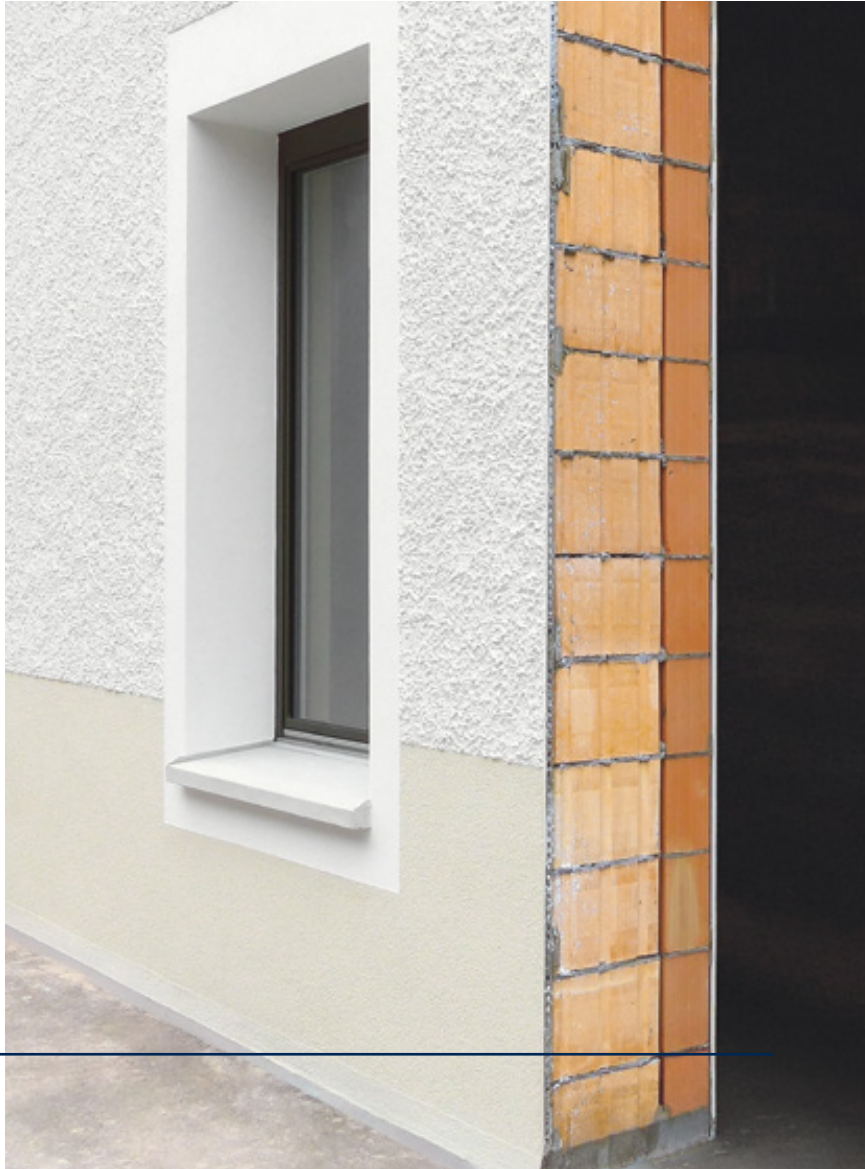
Ecco come si fa: struttura della facciata KISMUR nell'area della fabbrica di laterizi.
