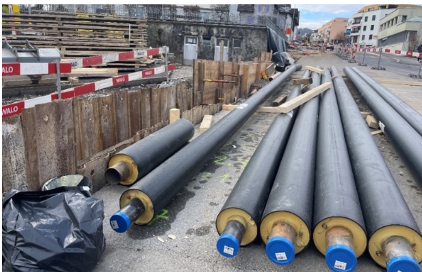
Installazione delle condutture di teleriscaldamento nel centro di Eschenbach.
