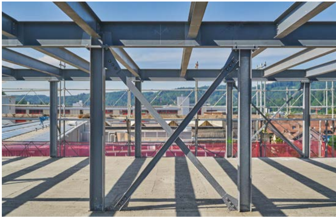
Figura 2.1: Quando si utilizzano componenti o intere strutture portanti, come in questo caso per la sopraelevazione del padiglione 118 a Winterthur, è necessario dimostrare che soddisfano i requisiti dell'edificio target. (Foto: baubüro in situ/ Martin Zeller)
