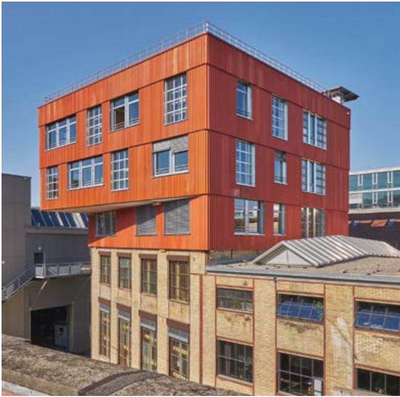
Figura 1.3: La facciata e la struttura portante dell'edificio di testa padiglione 118, di tre piani, situato nella Lagerplatz Areal a Winterthur, sono costituite in gran parte da componenti riutilizzati. (Foto: baubüro in situ/Martin Zeller)
