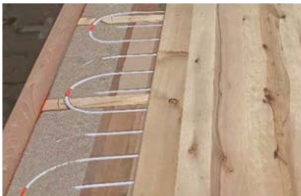
Figura 6.2: Struttura del pavimento nei piani uffici della «Casa del legno». I tubi del sistema di riscaldamento e raffreddamento non sono inglobati ma possono essere facilmente scollegati. (Fonte: PIRMIN JUNG Schweiz AG)
