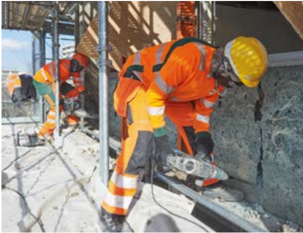
Figura 4.4: Da un vecchio rivestimento di facciata è stata ricavata una pavimentazione in terrazzo alla veneziana per gli spazi interni rinnovati. (Foto: Marcel Kohler/Eric Rossier)
