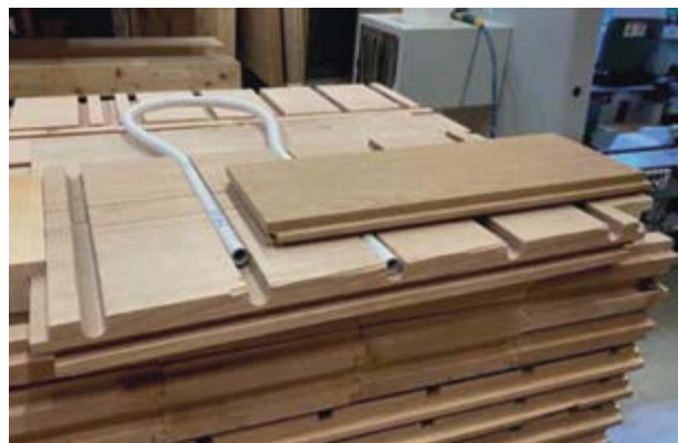
Figura 6.2: Struttura del pavimento nei piani uffici della «Casa del legno». I tubi del sistema di riscaldamento e raffreddamento non sono inglobati ma possono essere facilmente scollegati. (Fonte: PIRMIN JUNG Schweiz AG)
