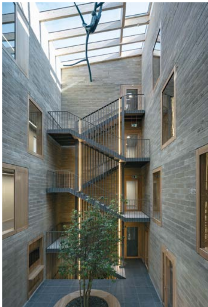
Figura 5.2: Uno dei due atri, che non solo porta molta luce naturale nell'edificio, ma, grazie all'effetto camino e ai mattoni di argilla incorporati, influenza positivamente anche il clima interno. (Foto: Duccio Malagamba)
