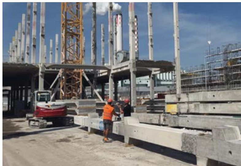
Figura 7.3: Pilastri, travi ed elementi del solaio dell'ex parcheggio Lysbühl a Basilea vengono smantellati elemento per elemento e saranno successivamente riutilizzati in due nuovi edifici. (Immagine: Muriel Mangold)
