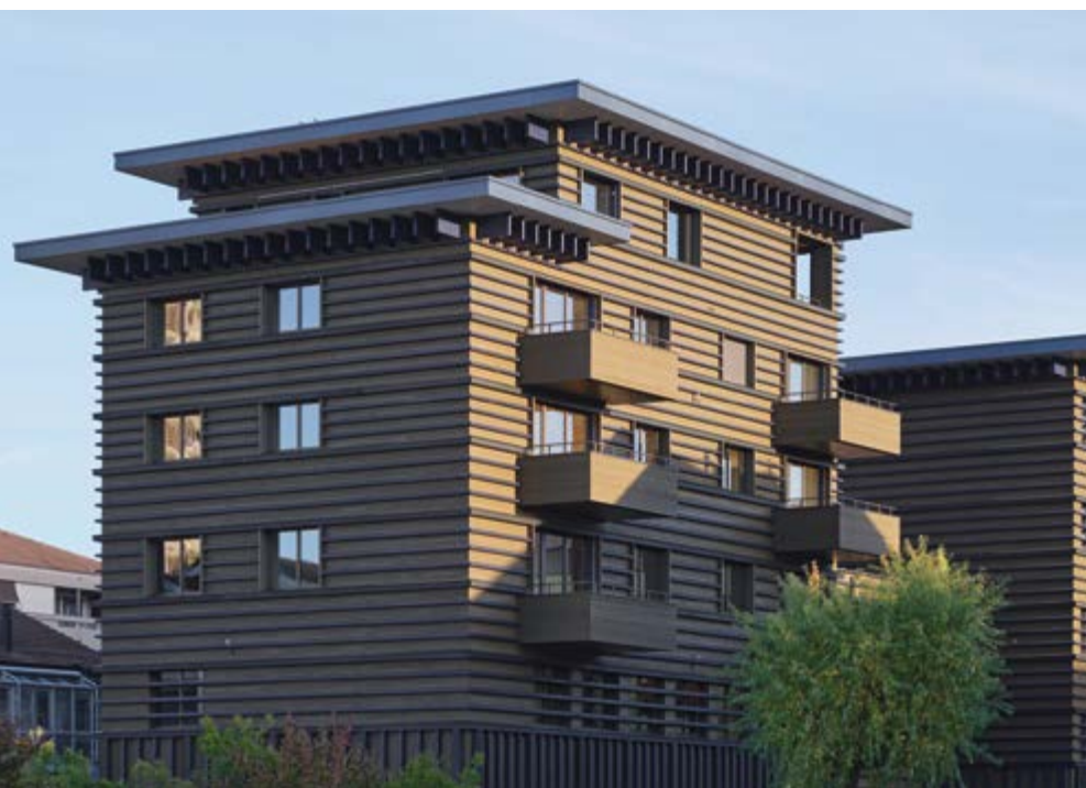
Figura 6.4: La «Casa del legno» è costruita quasi esclusivamente con legno locale. (Foto: Marcoleu GmbH)
