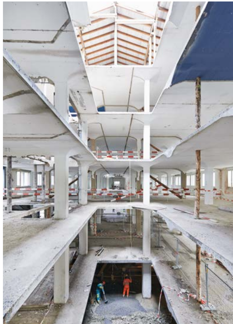
Figura 3.5: Per creare nuovi vani scale sono stati necessari tagli nella struttura portante. (Foto: Studio Gataric Fotografie)
