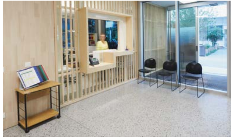
Figura 4.4: Da un vecchio rivestimento di facciata è stata ricavata una pavimentazione in terrazzo alla veneziana per gli spazi interni rinnovati. (Foto: Marcel Kohler/Eric Rossier)
