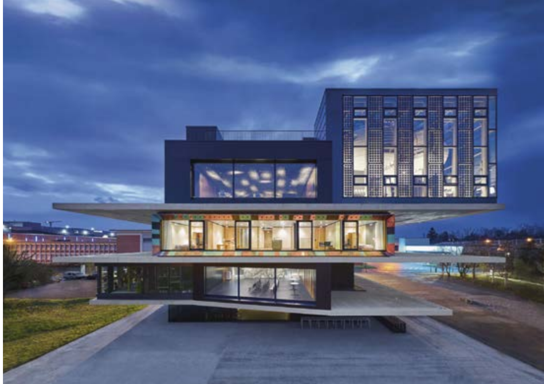
Figura 7.4: L'Unit «UMAR» è situata sulla piattaforma centrale. Sono ben visibili le lastre di rame riutilizzate sotto e sopra le finestre: le diverse tonalità di colore sono dovute all'ossidazione. (Foto: Zooey Braun, Stoccarda)
