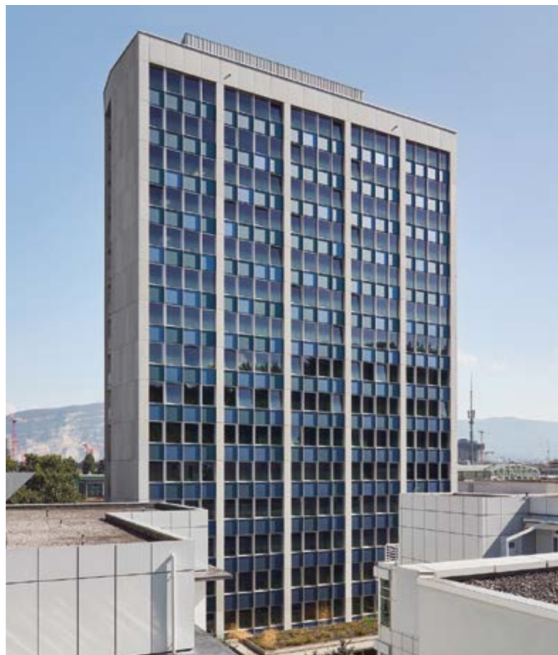
Figura 4.3: La torre di 16 piani, un tempo utilizzata dal produttore di profumi Firmenich, ha beneficiato di un rinnovamento estetico attraverso l'installazione di moduli fotovoltaici colorati sulle facciate e ora genera energia solare rinnovabile. (Foto: Eric Rossier)
