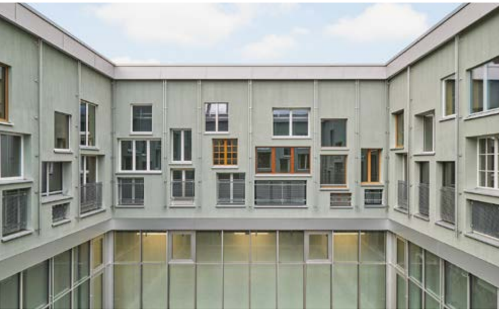
Figura 4.2: Per la Kultur- und Gewerbehaus Elys a Basilea sono state riutilizzate 200 finestre che differiscono notevolmente per colore, forma e materiale. (Foto: baubüro in situ/Martin Zeller)
