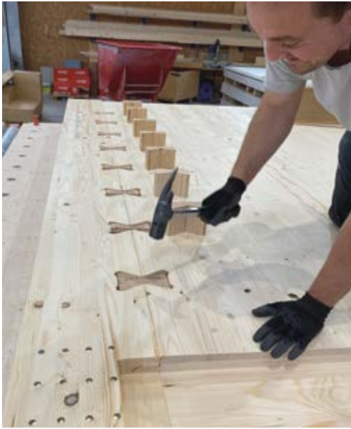
Figura 6.5: Per garantire la separabilità dei componenti, i progettisti di costruzioni in legno puntano su collegamenti a incastro e a vite. (Foto: Tschopp Holzbau AG)
