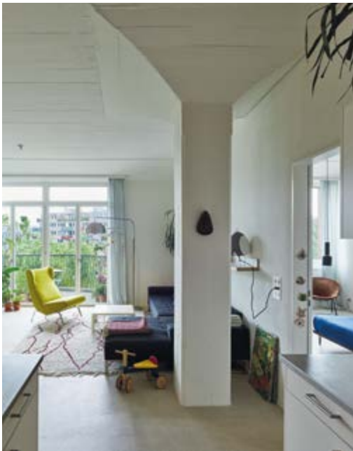
Figura 3.3: I caratteristici pilastri a fungo sono stati integrati negli spazi. (Foto: Georg Aerni)
