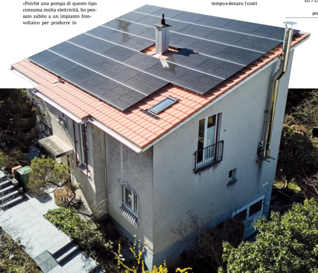
Nella casa unifamiliare di Riehen il tetto è stato risanato in contemporanea con l'installazione di un impianto fotovoltaico.
